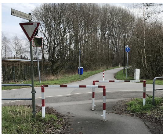
Umlaufsperrung auf der Kohlenbahntrasse
